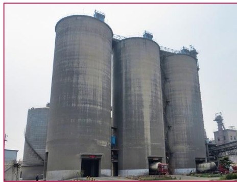
Строительство систем хранения золошлаков
