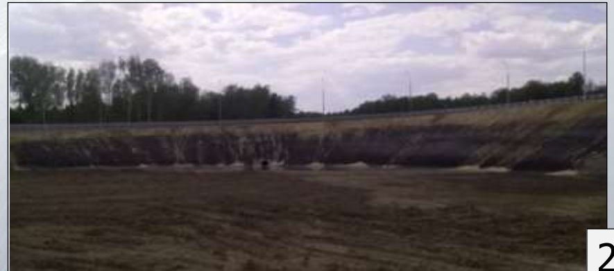
Наличие размывов (нет укрепления откосов)
