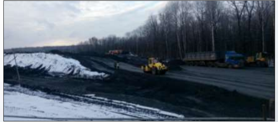
Наличие размывов (нет укрепления откосов)
