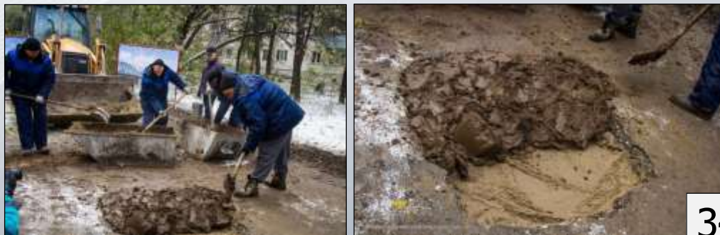
Академгородок, ремонт выбоин покрытия золобетоном (г. Новосибирск, 2016 г) :
