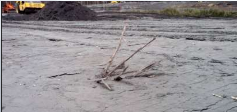
Наличие включений (не подготовлен отвал)
